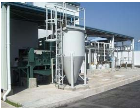
Khu xử lý nước thải
